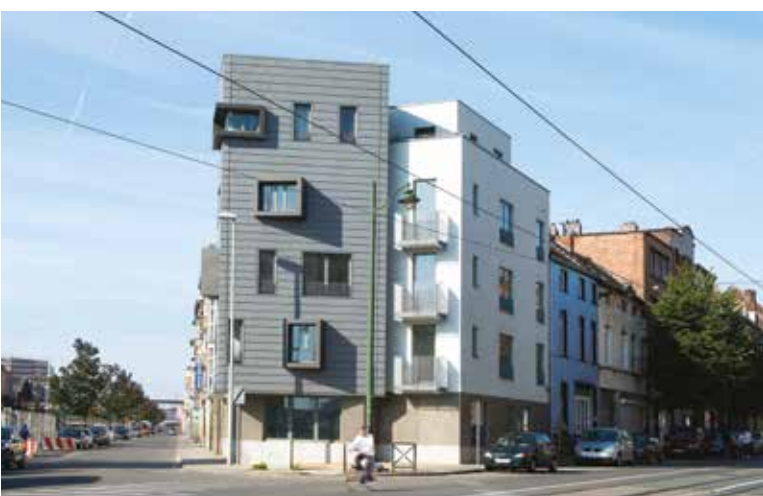
Quai de Mariemont, à Molenbeek : un immeuble de 9 logements en Community land trust. © Marc Detiffe pour SPRB - DRU
